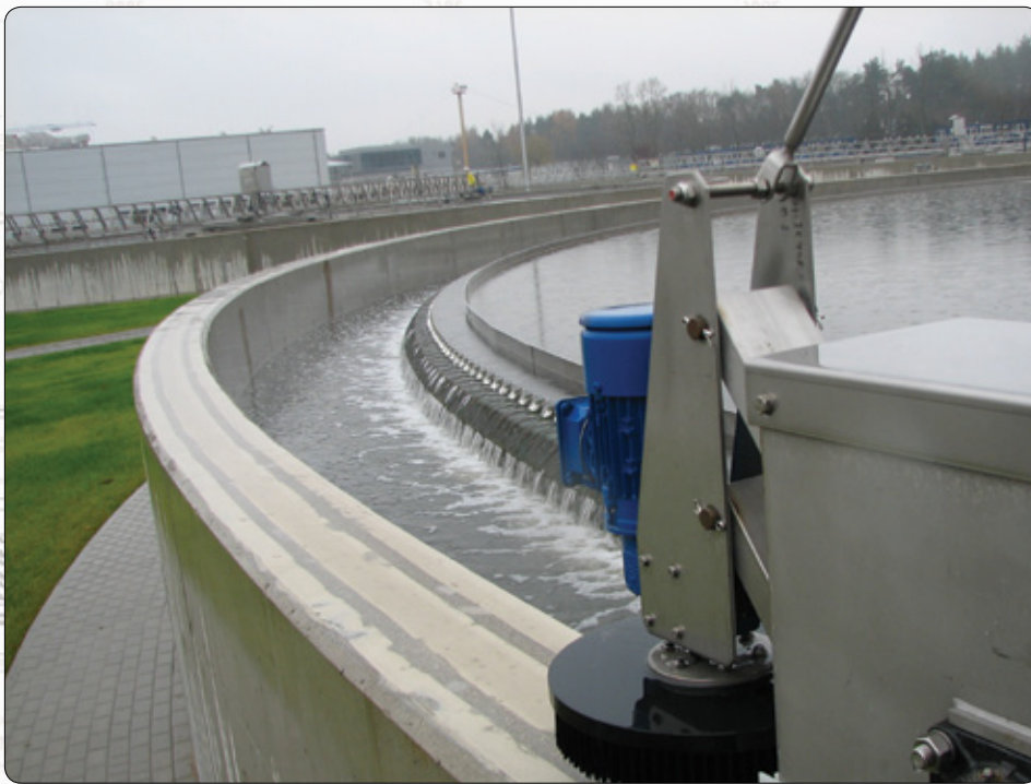
Fragment osadnika wtórnego. Fot. Archiwum MPWiK.
